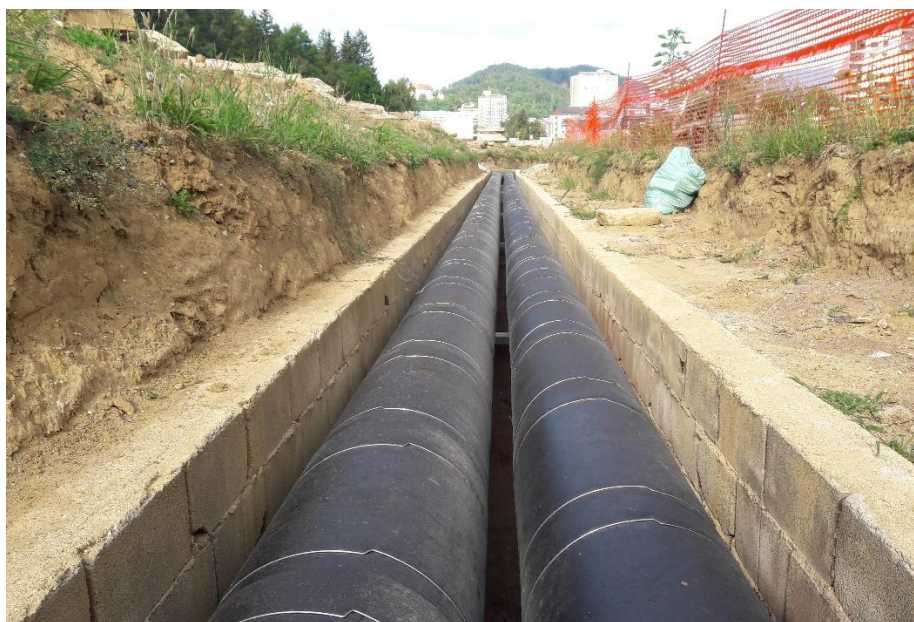
Slika 8: Obnovljena izolacija vročevoda (pogled v smeri J 5517)
