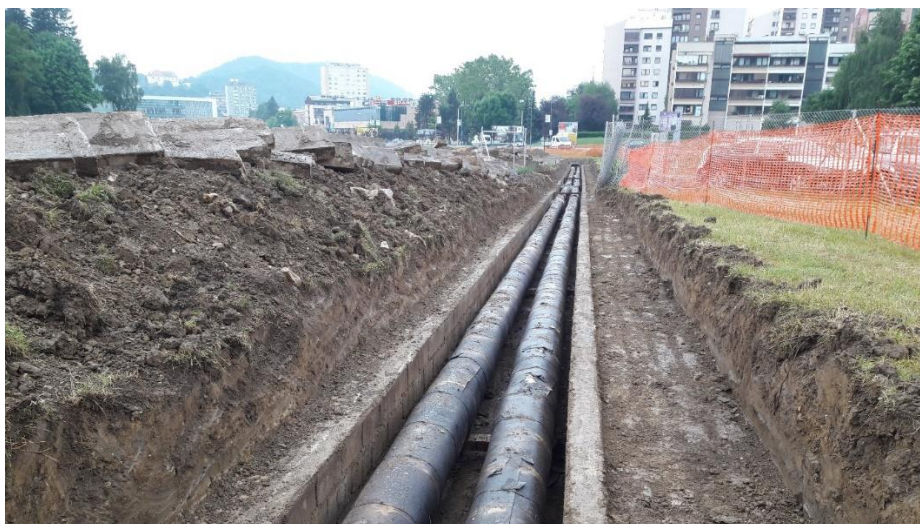
Slika 4: Odpiranje kinete vročevoda (pogled v smeri J 5035)
